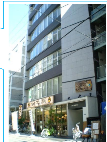
ピカソ備後町ビル 3階
